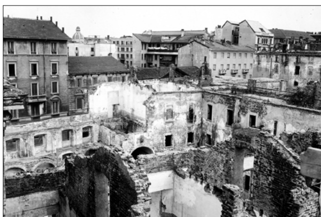
Veduta aerea dell'edificio bombardato verso via San Vittore, 1943
