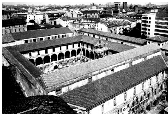
Veduta aerea dei chiostri durante i lavori di ricostruzione, fine anni '40 del XX secolo
