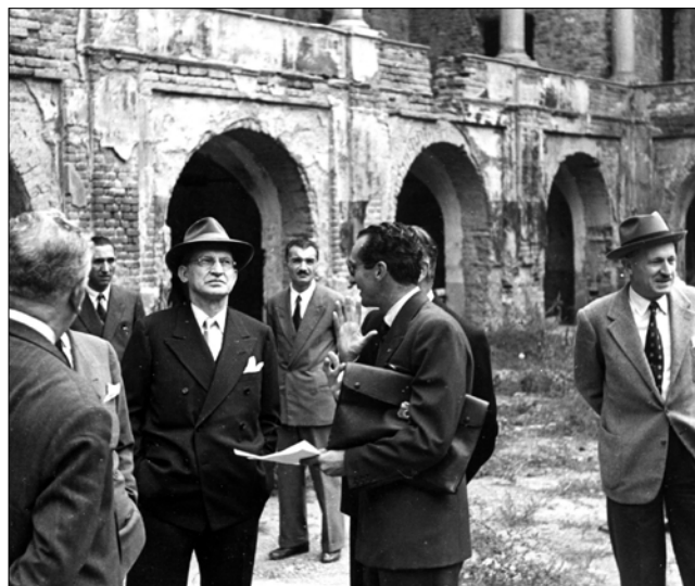
Il presidente del consiglio Alcide De Gasperi in visita al cantiere, 1948 ca.
