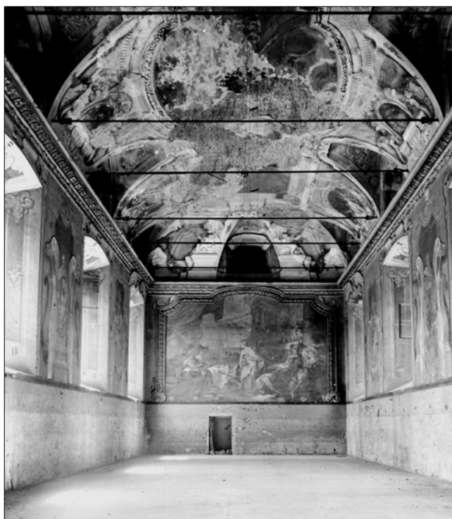
L'ex refettorio prima del restauro di Ottemi Della Rotta, con le evidenti cadute di intonaco dalla volta e i danni del tempo, 1948
