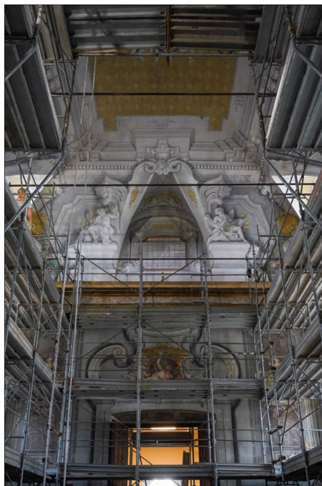
Le quadrature architettoniche della volta durante il restauro, 2023
